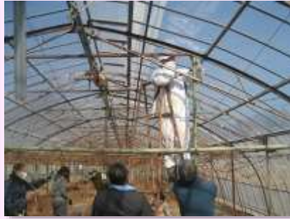
ブドウ棚の補強作業
